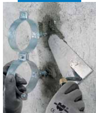
Montaż uchwyty do rur przy użyciu Lampocem
