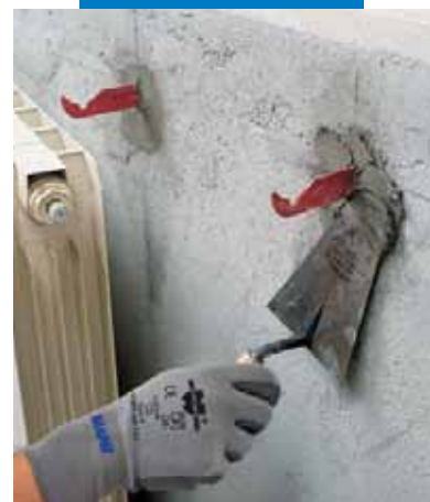
Mocowanie wieszaka kaloryfera z zastosowaniem Lampocem
