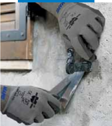
Zastosowanie Lampocem do mocowania śrub kotwiących okiennice
